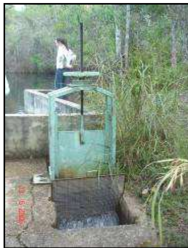
Figura 3 – Canal de Derivação na Captação de Água Cabeça de Veado I
